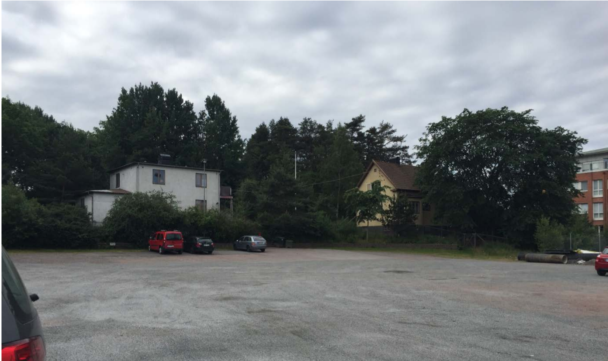
Foto 7. Högsbo 2:2, med två äldre villor från 1936 bevarade. Tidigare plats för lastbilscentral, en mindre sanering av förorenad jord har utförts runt en dieselcistern. Idag bedrivs hunddagis och småindustri på platsen.
