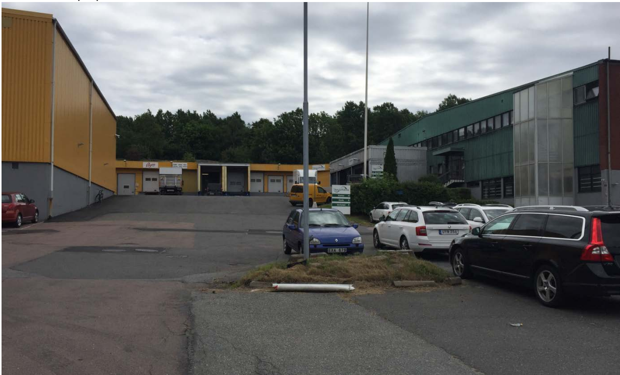
Foto 8. Högsbo 3:10, olika asfaltsbeläggningar med varierande ålder.
